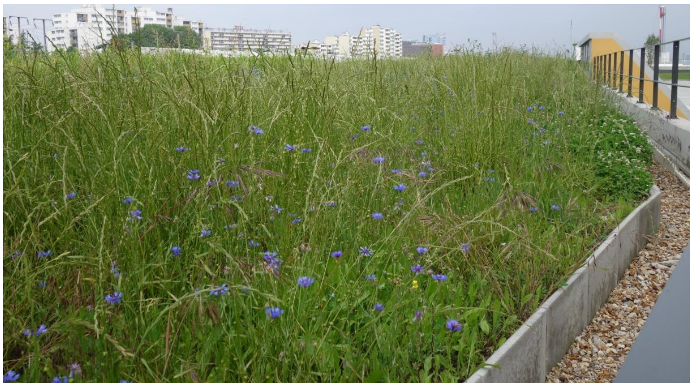
Figure 10 - Exemple de prairie en toiture inaccessible
